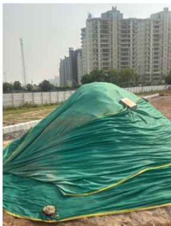
डस्ट स्क्रीन से ढकी कंस्ट्रक्शन मटेरियल
